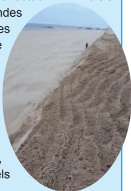
Pointe du Cap Ferret : rechargement de sable
